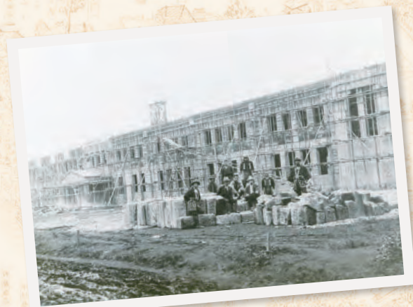
大正13年の東葛飾中学校の校舎の建築現場
