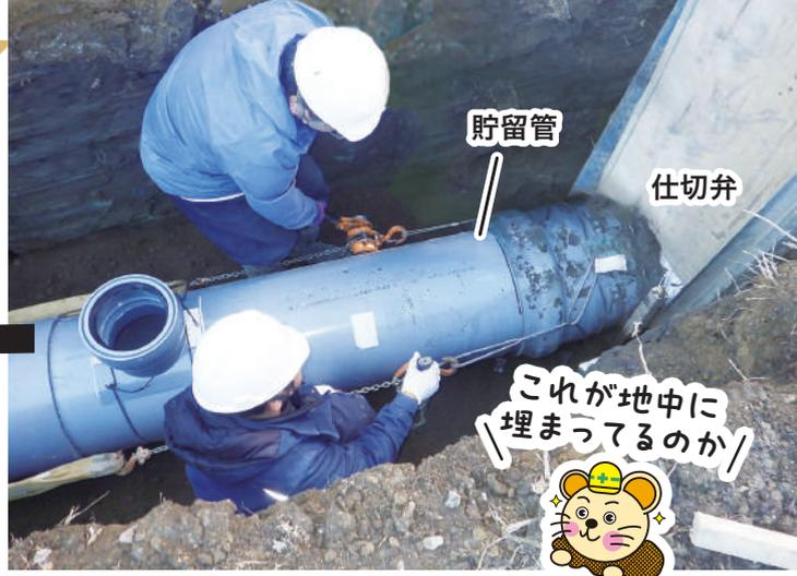
工事は、便器設置部分から下水管への接続部分までを整備するものです。初めに、地中に水道管やスプリンクラーなどが埋まっていないかを確認するための試掘(しくつ)を行います。問題なければ深さ1.5メートル程度の穴を掘り、管の設置を進めていきます。およそ4~6カ月で工事が完了します。
