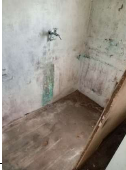
風呂釜・浴槽は 入居者の費用で設置
