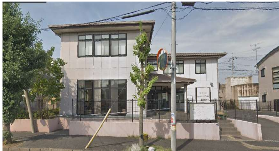
ほんのぼのプラザますお外観(増尾駅より約600m)
