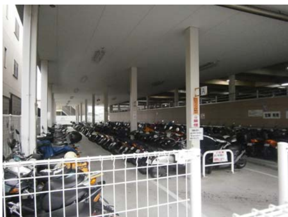
1階(原動機付自転車駐輪スペース)
