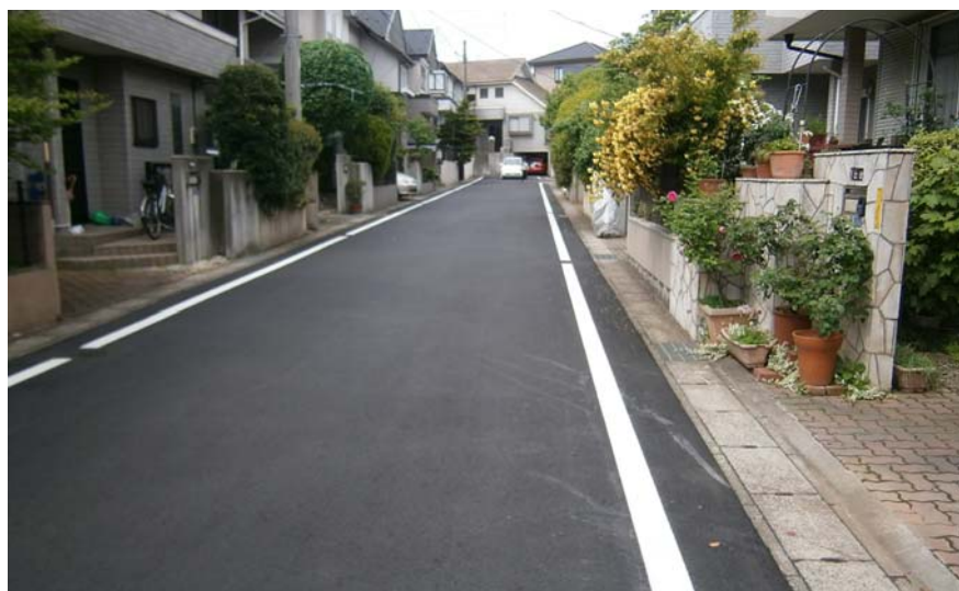
柏市藤心地先舗装復旧工事（柏市藤心一丁目）
