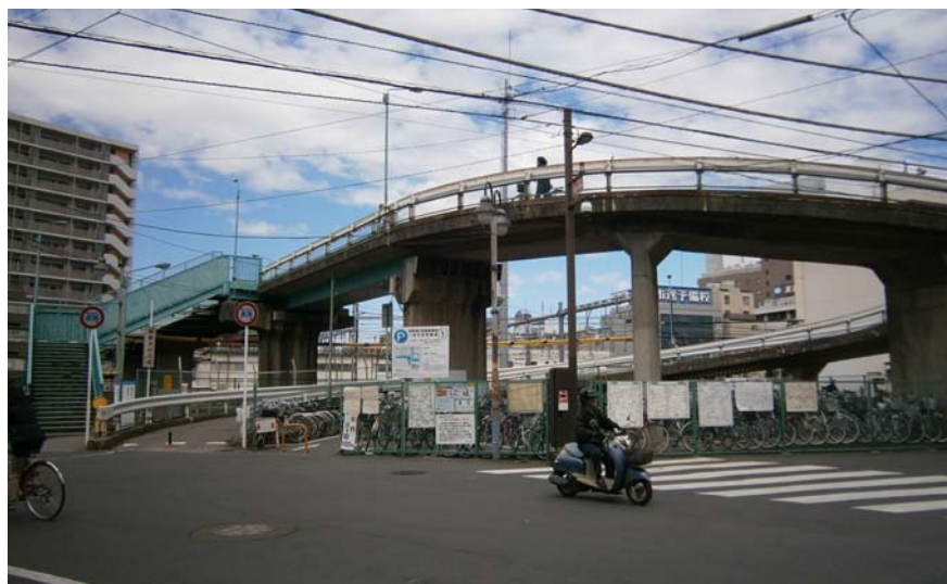
第二流山街道こ線橋橋脚補修工事（柏市柏一丁目）
