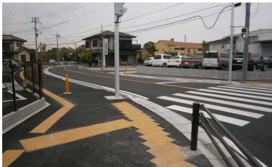
新市建設計画道路改良工事（24-1-3）（柏市大井）
