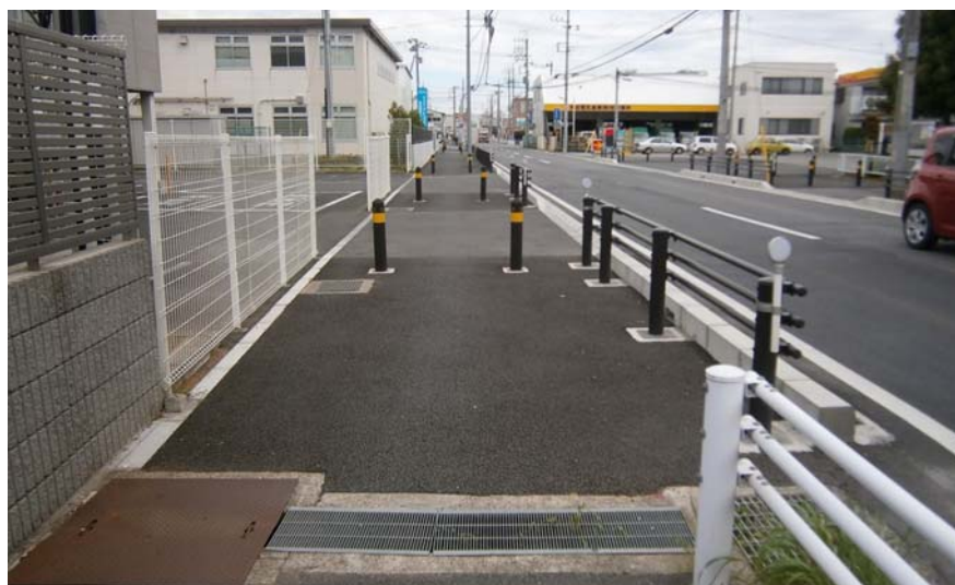
旧西口三号線歩道整備工事（柏市高田）
